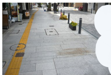
市道歩道への 点字ブロック敷設
