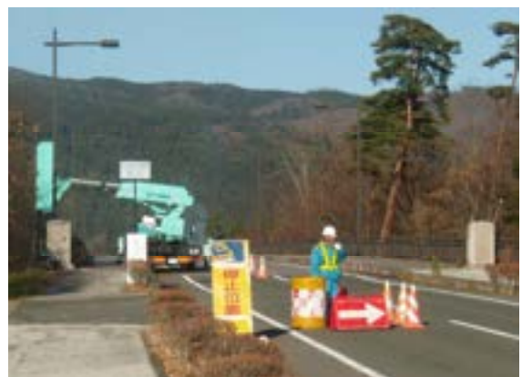
詳細点検の例（橋梁点検車使用）
