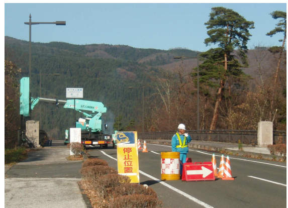
詳細点検の例（橋梁点検車使用）
