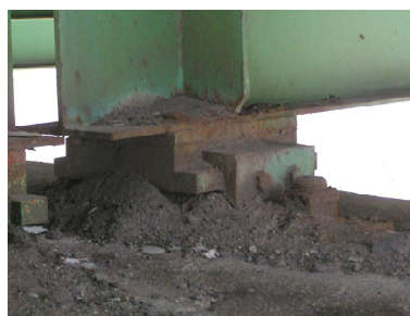
支承部の土砂堆積
