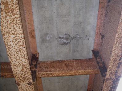
鋼主桁の腐食
