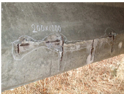
コンクリート主桁の剥離・鉄筋露出
