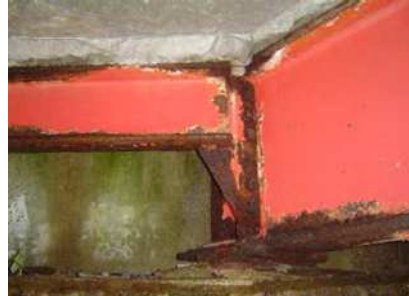
鋼主桁端部の腐食
