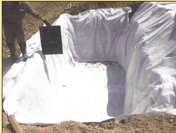
②透水シート設置
