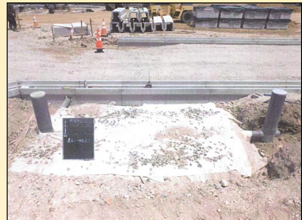
④宅地内貯留施設設置完了
