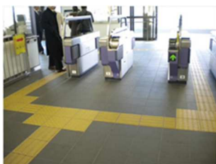
誘導ブロックの設置例
