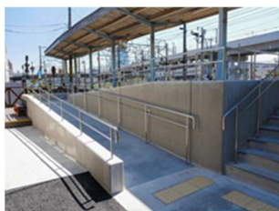
スロープの整備(曾根田駅)
