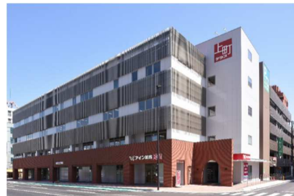
店舗棟（上町テラス）完成写真
