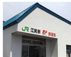
駅舎の新改築・移設
