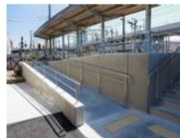
スロープの整備（曾根田駅）
