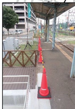
ホームに柵が無くて危険
