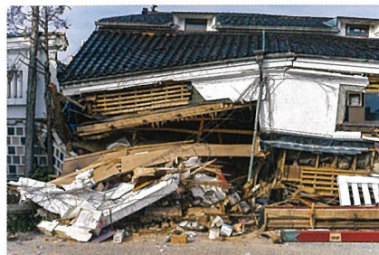
地震による被害例 (能登半島地震)
