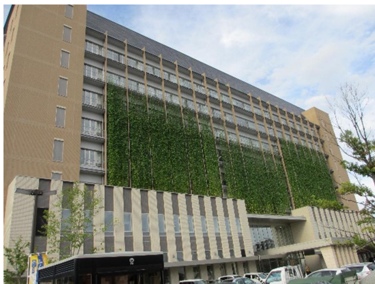
市役所本庁舎へのグリーンカーテンの設置
