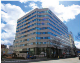
《01 福島セントランドビル》
