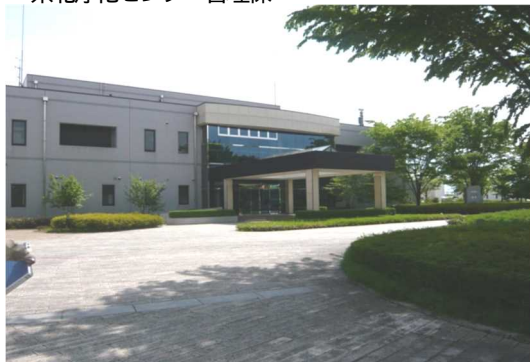
県北浄化センター管理棟
