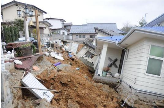
法面崩落による家屋損壊
