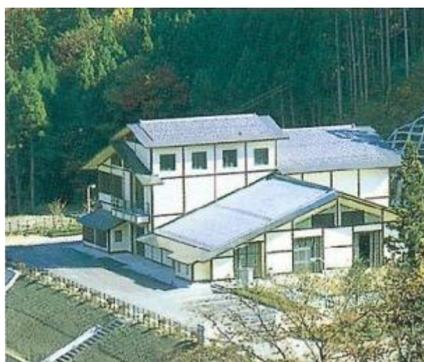
図 1-3 土湯温泉町浄化センターの外観
