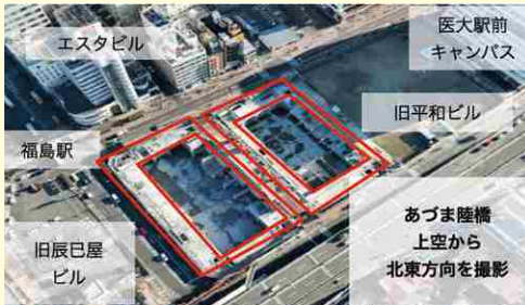
土留用に残したコンクリート壁面
