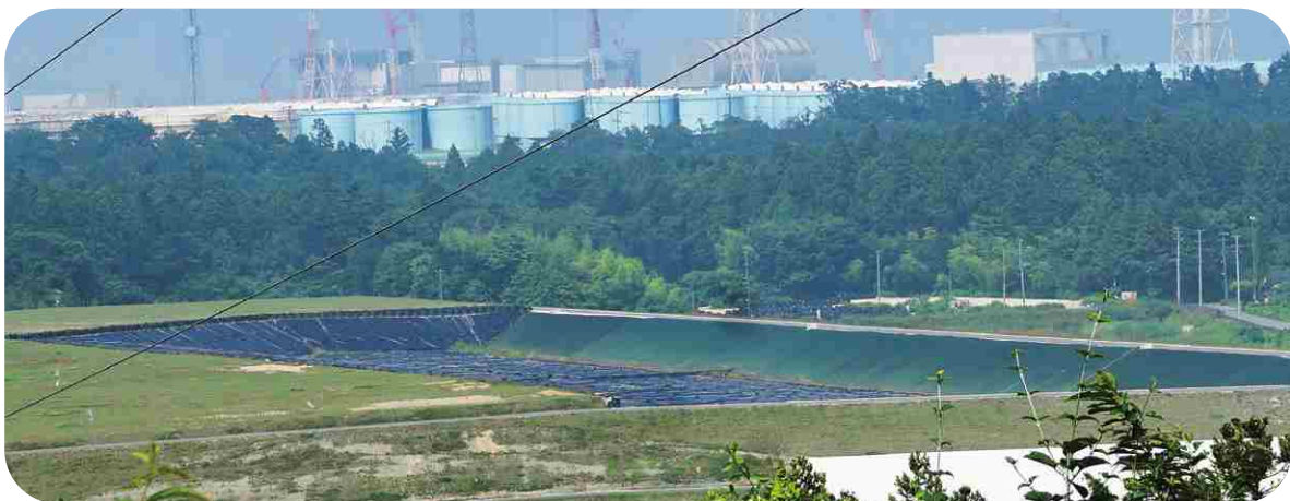
見晴台から望む福島第一原発と大熊第4工区土壌貯蔵施設
