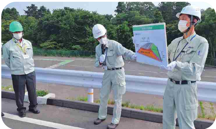
除去土壌の再生利用に向けた道路盛土実証の現場
