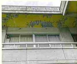
修繕予定の小學校外壁
