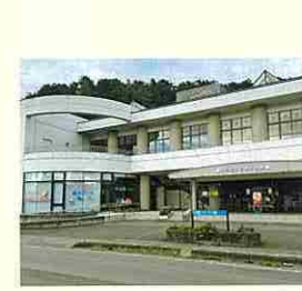
改修工事予定のヘルシーランド福島
