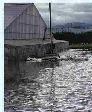
台風被害を受けたビニールハウス(鎌田)
