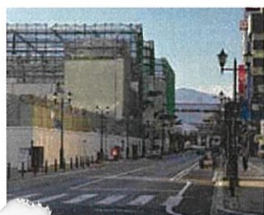
解体がすすむ東口再開発事業 (11月末現在、解体率72%)
