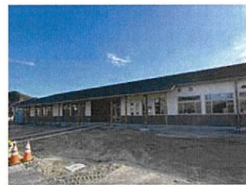
間もなく完成する新しい清水支所
