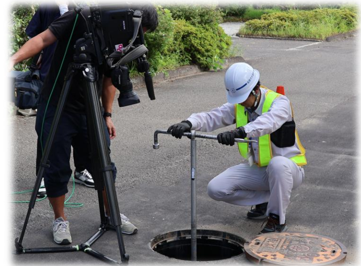
水道工事の作業風景をテレビ取材している状況
