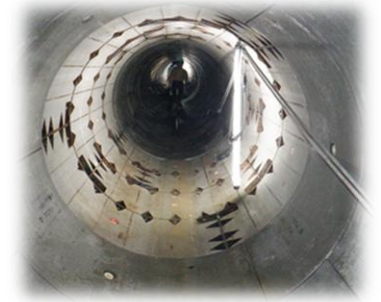
セグメント施工(イメージ)
