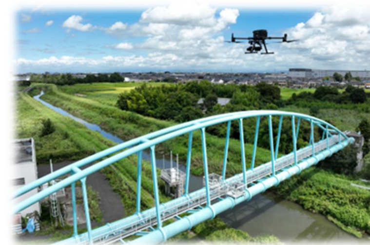
水管橋ドローン点検（イメージ）
