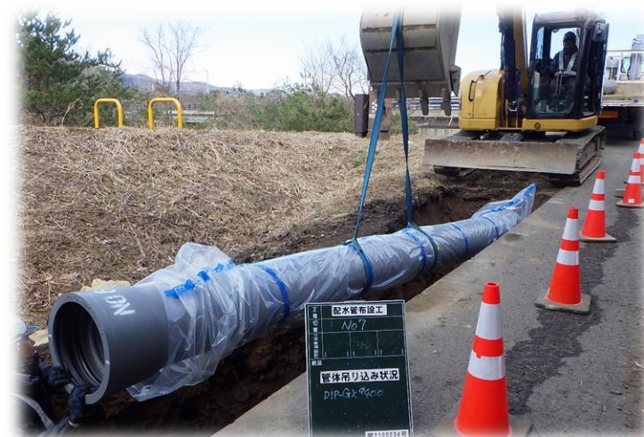
φ400mmの耐震管で更新工事を行っている状況
