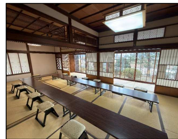
【エアコン設置：5・6号室】
