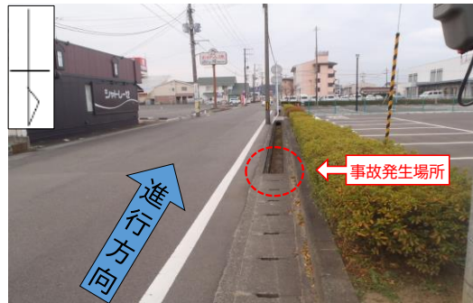
▼事故現場(全景)
