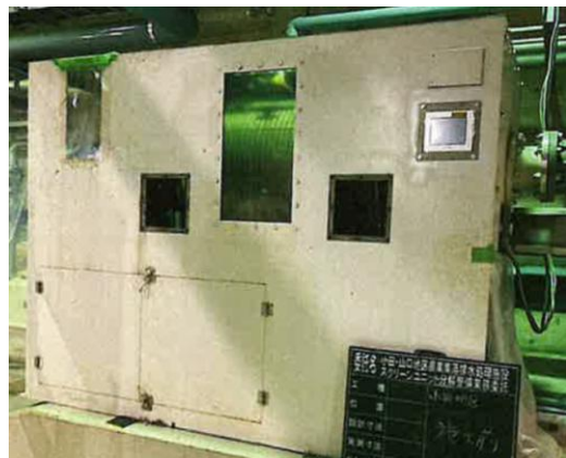
小田地区排水処理場 スクリーンユニット の分解整備
