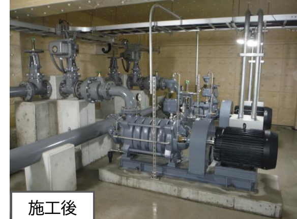
舘ノ前加圧ポンプ所送水ポンプほか更新工事
