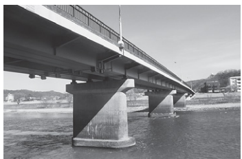
長寿命化修繕事業を行う天神橋
