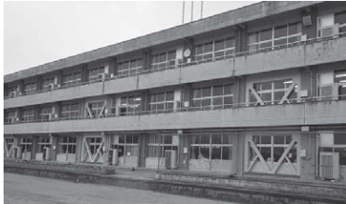
耐震化工事後の校舎
