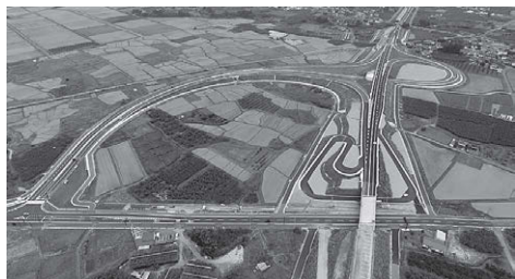
福島大笹生インターチェンジ
