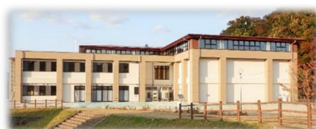
バリアフリーと防災機能を備えた学習センター (渡利学習センター)
