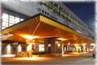
駅西口大庇美装化
