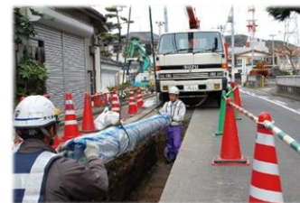
水道管耐震化
