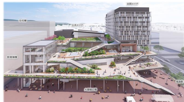
駅前通りの外観イメージ (屋上広場が道のように立体的につながり動的な印象)
