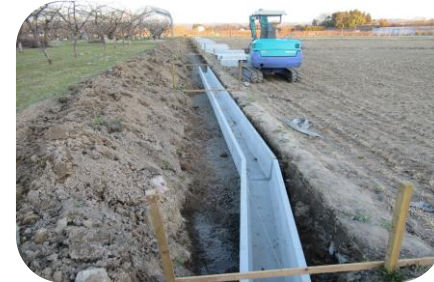
直営による水路整備
