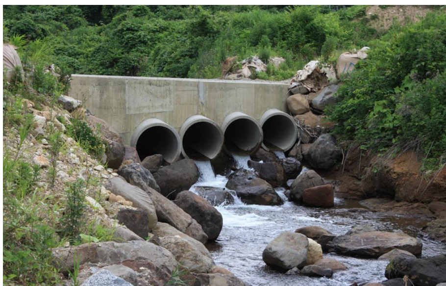
【写真-3】 砂防ダム工事の仮設暗渠 (水量測定箇所)
