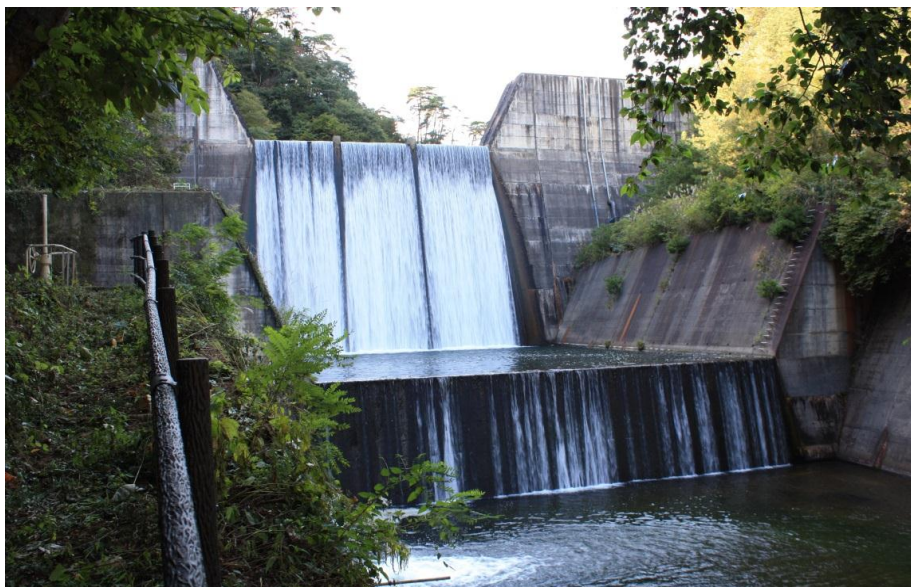
【写真-2】 ダム本堤からの放流管 (取水口に活用できる 可能性がある)
