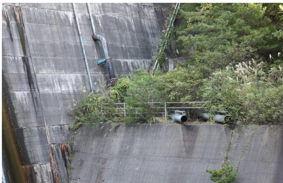
【写真-3】 小川堰の取水口(右岸側)
