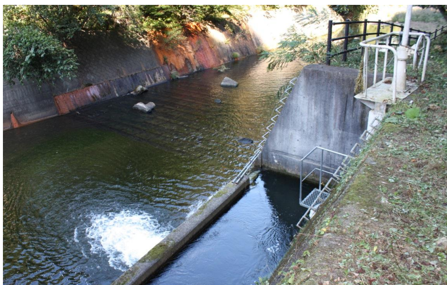
【写真-3】 小川堰の取水口(右岸側)
