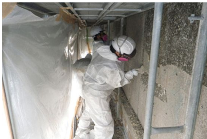
写真 アスベスト除去作業
