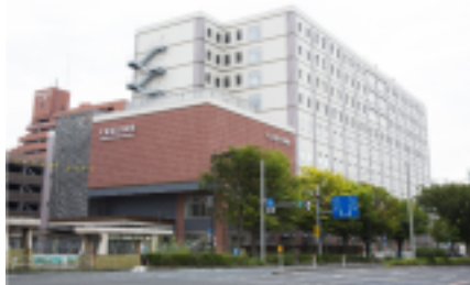
病院棟完成写真
