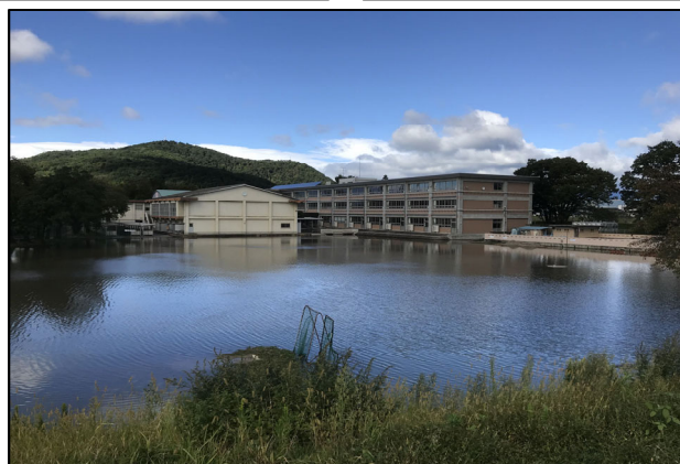
図 3-13 内水による浸水発生状況
