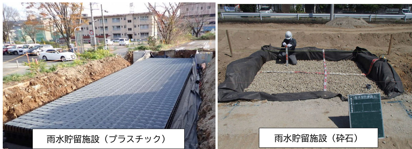
図 4-57 民間雨水貯留施設設置のようす
