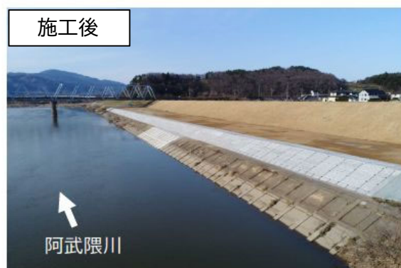
図 4-5 護岸復旧の状況
