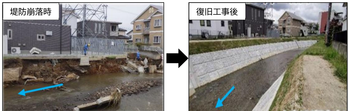
図 4-12 堤防復旧の状況
