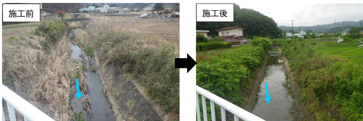
図 4-49 土砂浚渫の状況(胡桃川)
