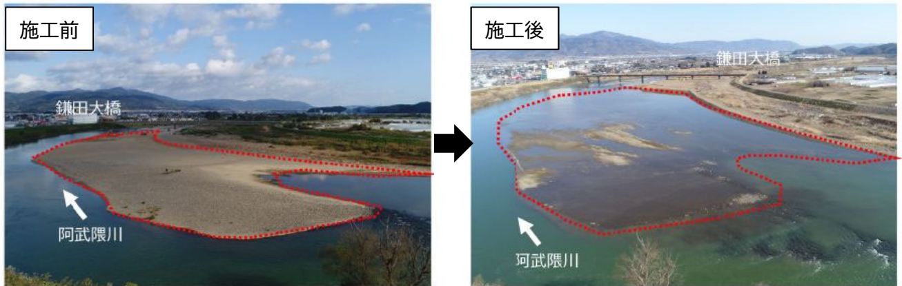
図 4-2 河道掘削の状況
