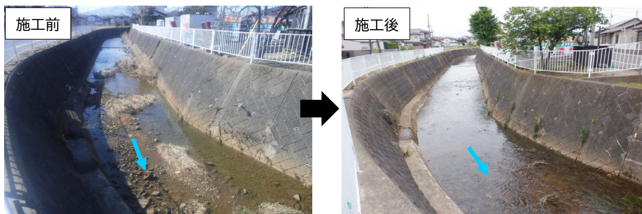
図 4-47 土砂浚渫の状況(耳取川)
