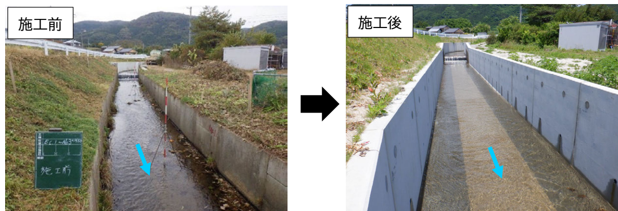
図 4-52 河川改修の状況(大堀川)
