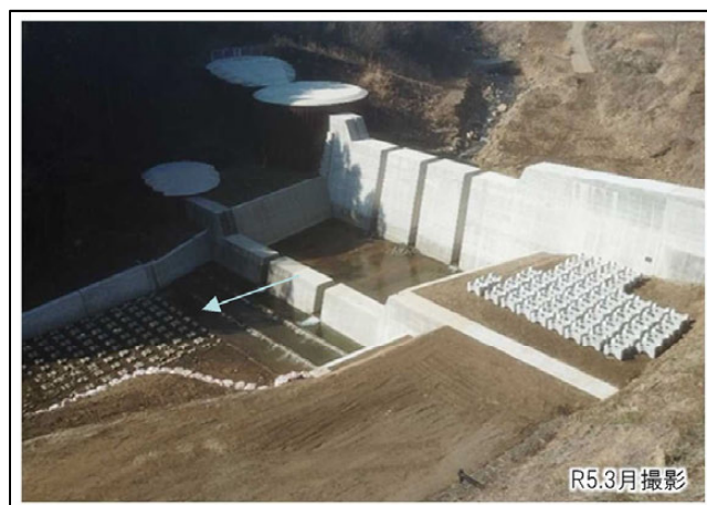
図 4-17 土砂対策の状況(東八川)
