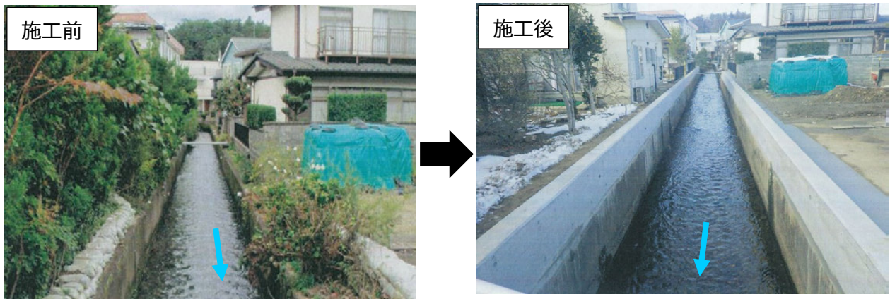
図 4-44 雨水渠(開渠)整備の状況
