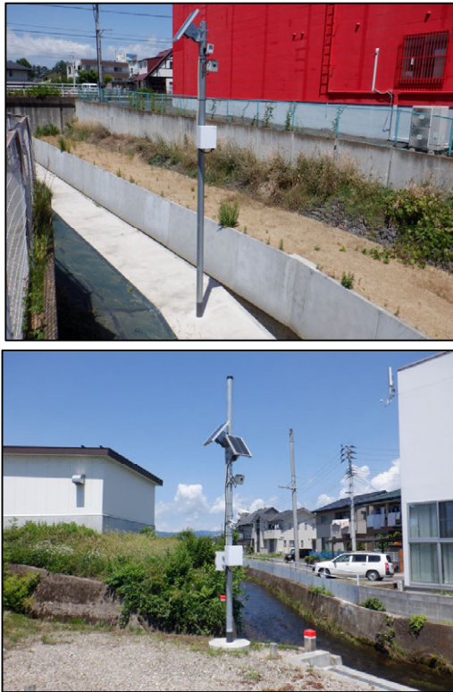
図 4-24 簡易型河川監視カメラ (上:鎌田樋管 下:曾根田橋(祓川))
