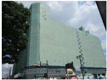
③ A街区 北西面 外部足場組立状況
