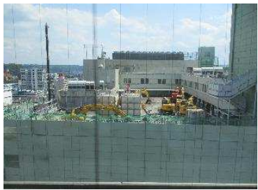
⑤ A街区 旧辰巳屋ビル 階上解体準備状況
