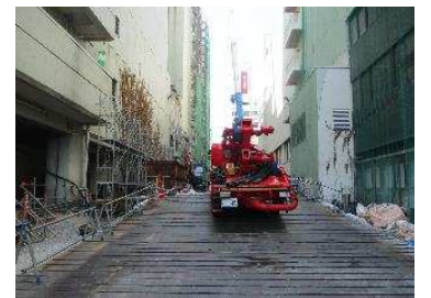
④ 覆工構台設置状況
