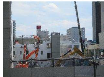
⑦ D街区 低層棟 解体状況
