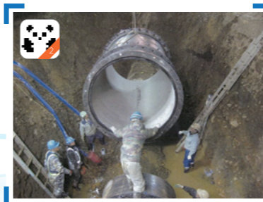
地震により破損した1500mm送水管(福島地方水道用供水企業団)の漏水状況(右)と補修状況(左)
