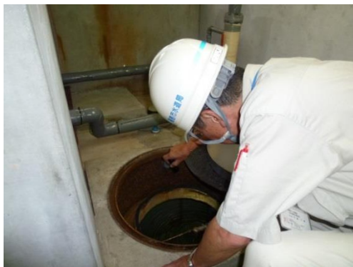
小規模受水槽点検状況
