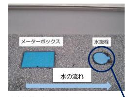
①水抜栓の場所を確認する。 (水抜栓は主にメーターボックスの近 くにあります。)
