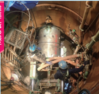
推進工事の様子
