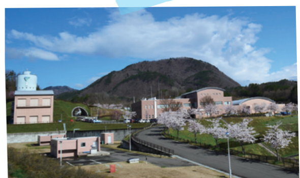
すりかみ浄水場は、摺上川ダムから取水し、地形の落差を利用した自然流下方式とするため、標高213メートルの高台に建っています。
