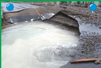
東日本大震災時の漏水と応急給水状況
