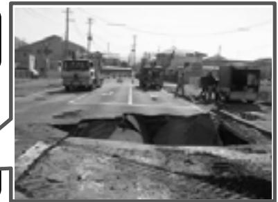
送水管φ600 破損（陥没）
