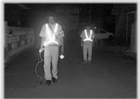
漏水調査業務（夜間路面音聴）
