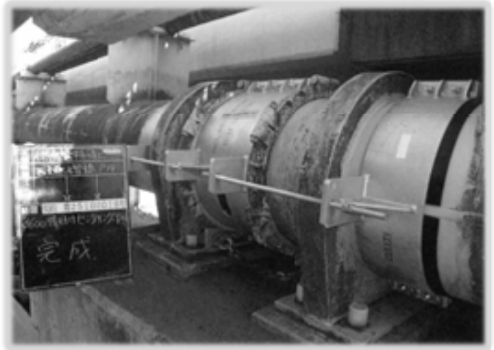
水管橋簡易耐震補強工事
