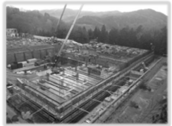
弁天山配水池耐震化更新工事
