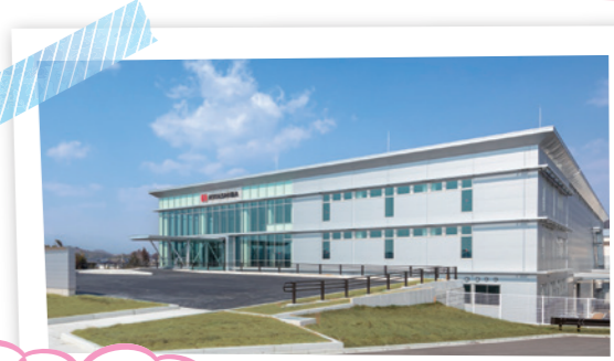
変圧器技術開発センター新工場が今年4月に竣工。 省資源・省エネルギーなどの取り組みにより、「平成28年度地球温暖化防止のための福島県定書」事業において最優秀賞の評価を受けました。
