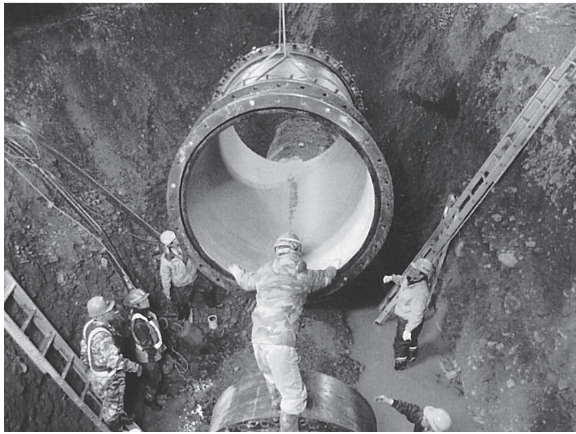
東日本大震災で損傷した送水管φ1500mmの補修状況(福島市飯坂町中野地内)
