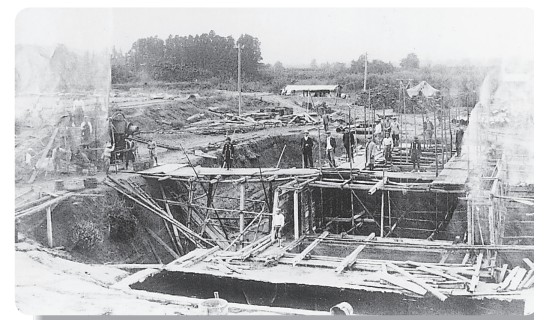
旧渡利浄水場の最初の工事
