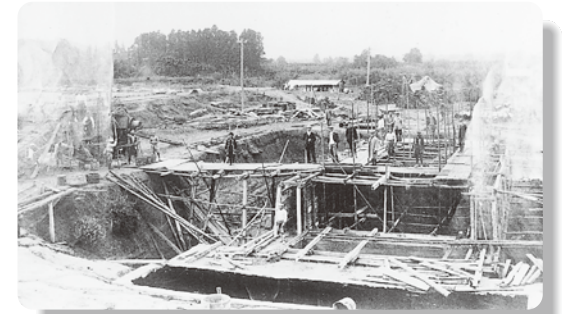
旧渡利浄水場の最初の工事
