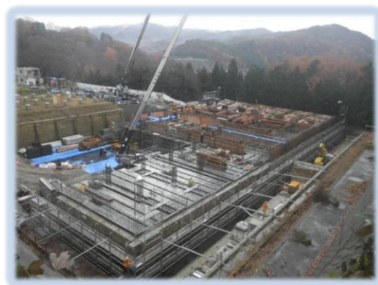
弁天山配水池耐震化更新工事
