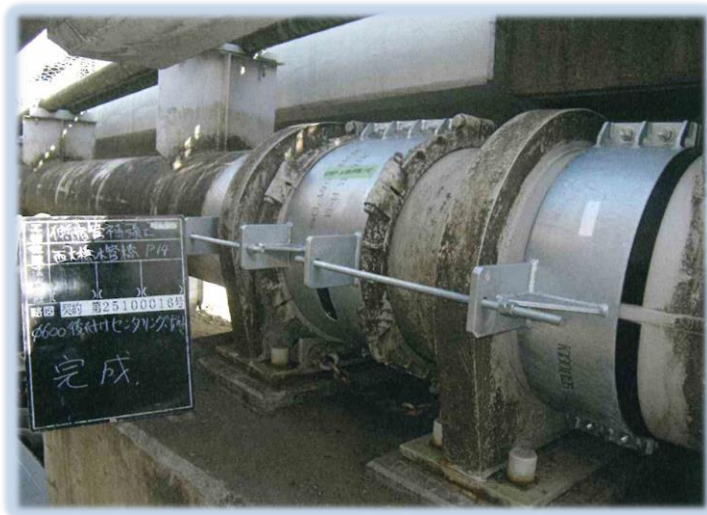
水管橋簡易耐震補強工事
