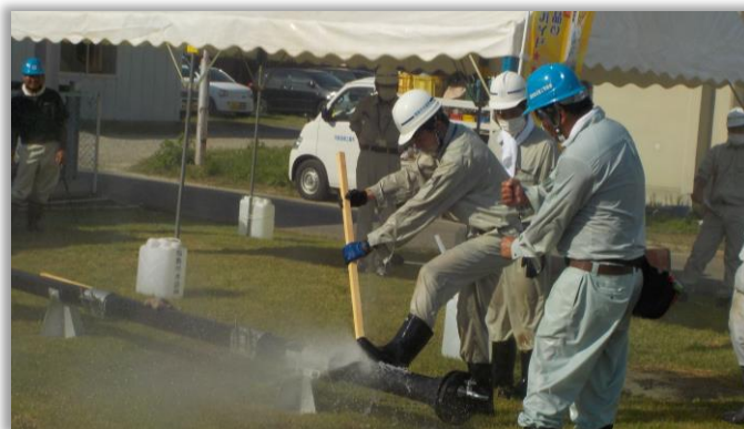
応急復旧訓練風景
